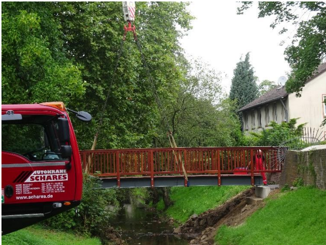
Endlich ist die neue Brücke da!!!
